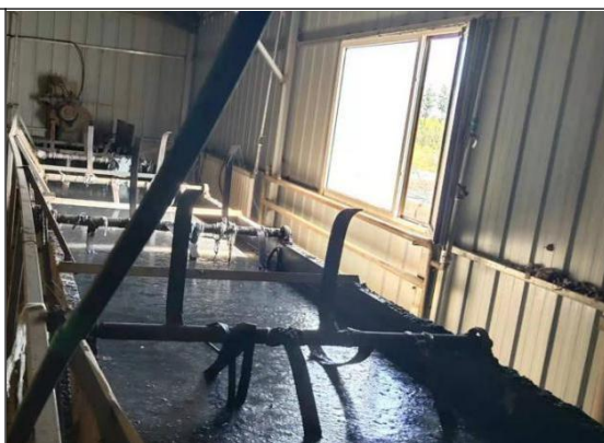
破碎清洗水池
