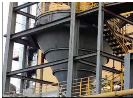
二期工程渣仓
