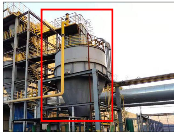
二期工程灰渣接收仓
