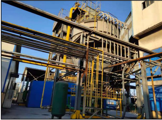
一期工程灰渣接收仓
