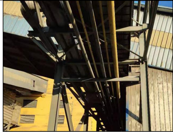
二期工程灰渣输送系统
