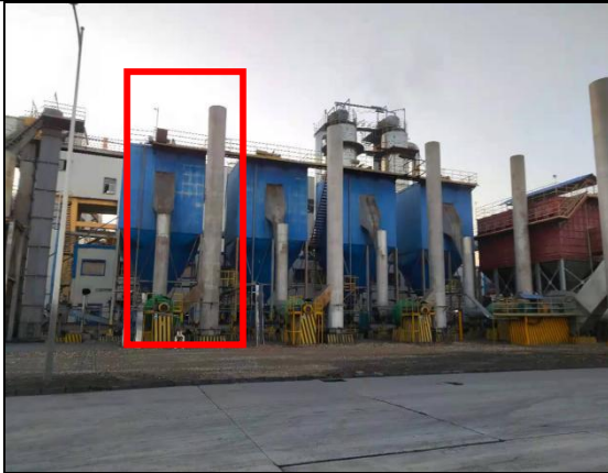
二期工程沸腾炉布袋除尘器
