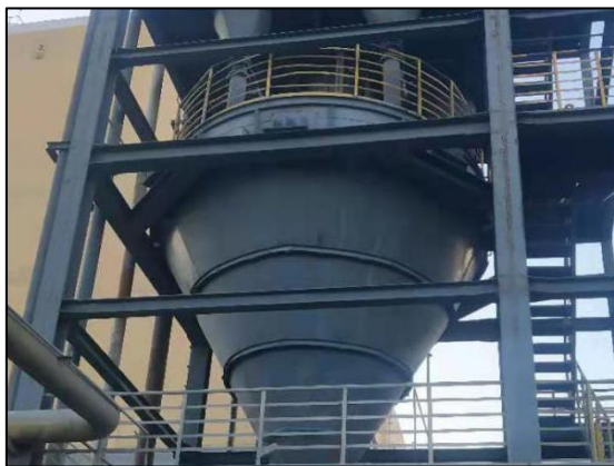
一期工程渣仓
