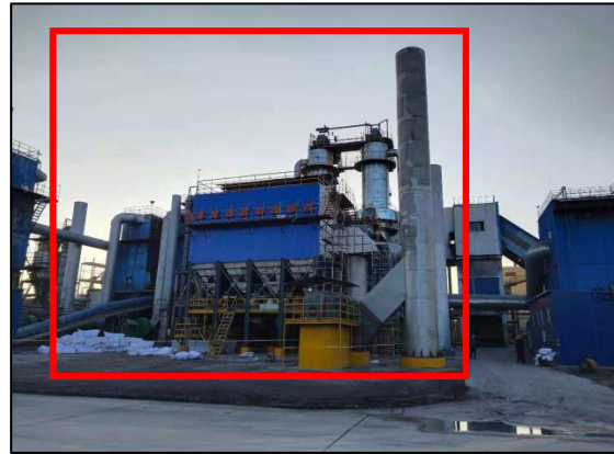
一期工程沸腾炉布袋除尘器
